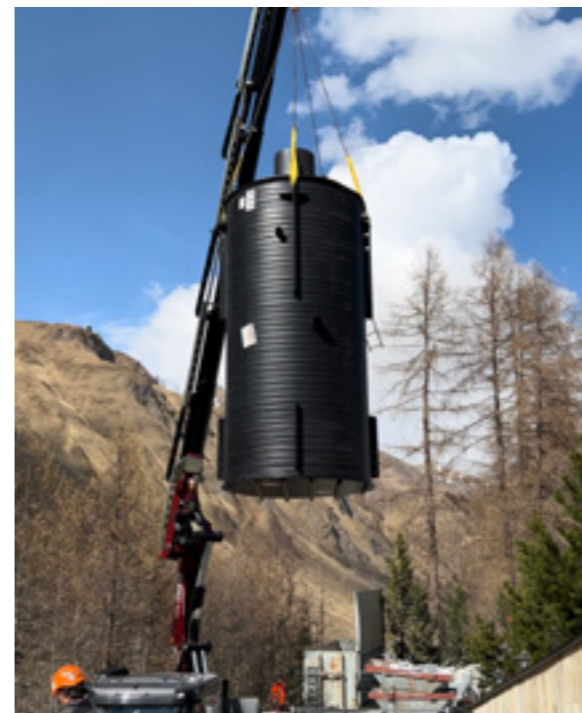
Oktober 2022: Ausgeklügelte Technik für die Wärmerückgewinnung wird geliefert und installiert
